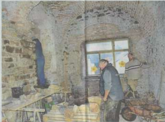
Marek Kočovský (uprostřed) se raduje z nových kachlí. Právě dorazila dodávka materiálů na stavbu kamen, která budou vytápět zrekonstruovanou zaječovskou Zedňou. FOTO: JIŘÍ ŠVABDILK
